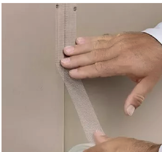
Tratamiento de junta de paneles de gypsum
