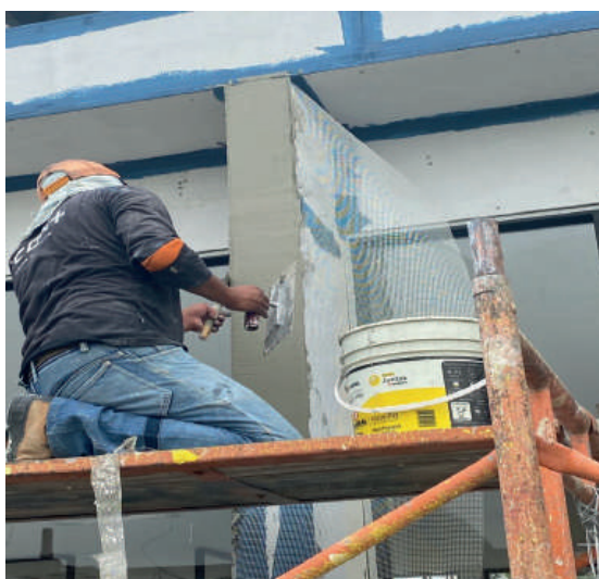
Aplicación en el proceso de enlucido
