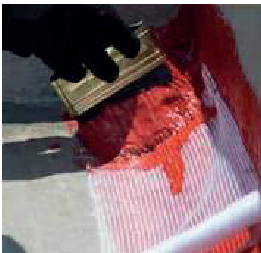
Refuerzo de rastreras o esquineras
