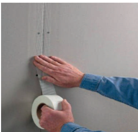
Tratamiento de junta de paneles de gypsum
